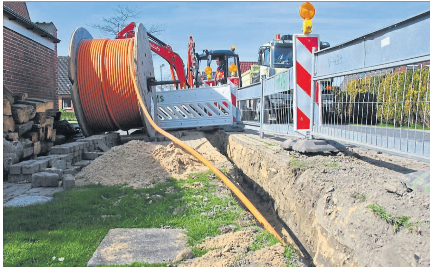
Verlegung von Leerrohren für Glasfaserleitungen in Dithmarschen.
